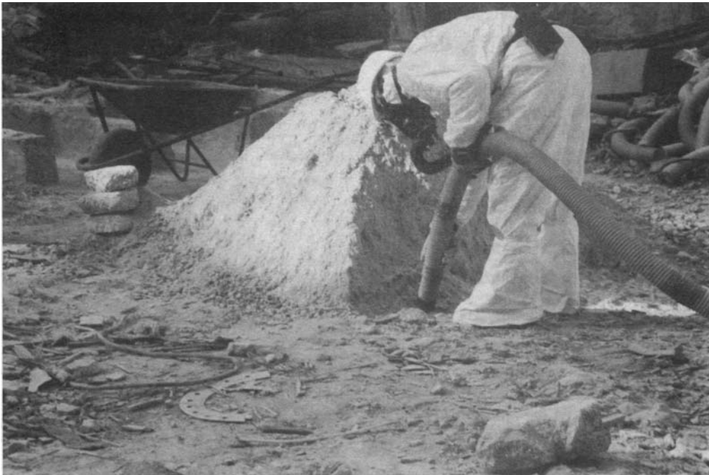
Fig. 1. Lo zuccherificio di Crevalcore: lavori di decontaminazione
